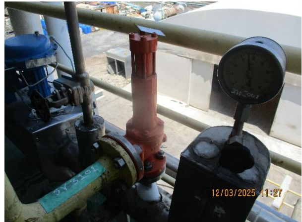
รูปที่ 25 การติดตั้ง Safety Valve
