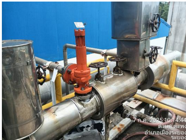
รูปที่ 25 การติดตั้ง Safety Valve
